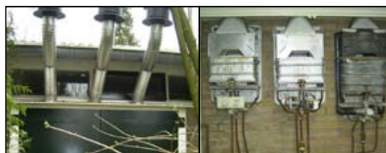
De oude situatie; 3 geisers met rookgasafvoeren
